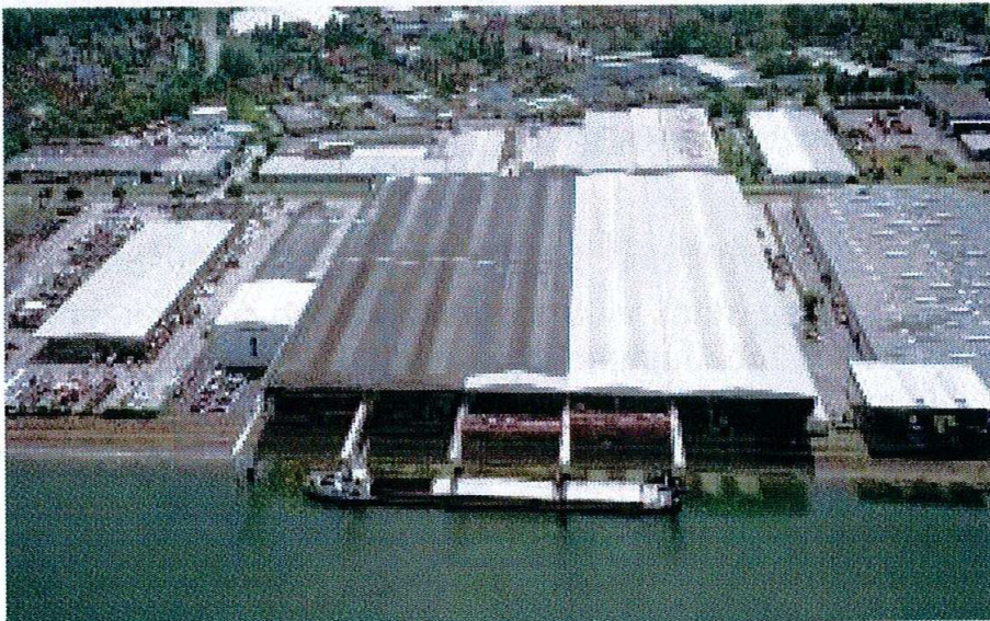
Die Lagerhalle der Carl Spaeter Südwest GmbH mit ihrem Zugang zum Rheinhafen
